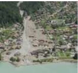
Glyssibach, Brienz; Foto: Swiss Air
